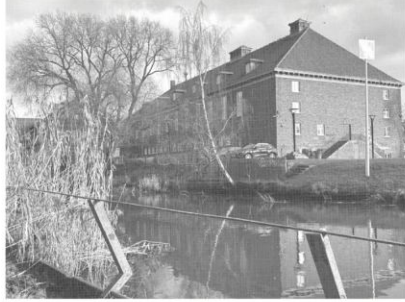
1. Vue sur les berges abruptes et dégradées
