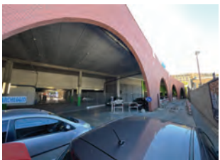
garage de stationnement privé
