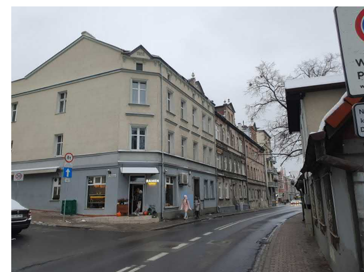
1. section de rue trop étroite
