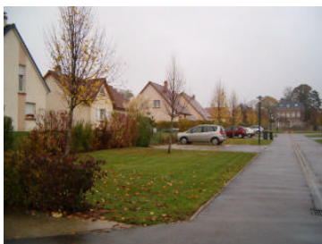
Opération d'habitat à ELBEUF (76) Les espaces libres devant les habitations et les circulations douces contribuent au bien-être des habitants.
