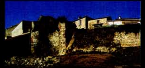
Les remparts avant travaux
