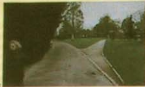
2 Le parc du souvenir : La nuit l'axe de circulation dans le parc est peu repérable pour les personnes mal-voyantes. Les intersections ne sont pas marquées.
